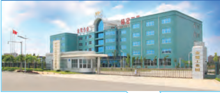
Завод в Тунъань 2009
